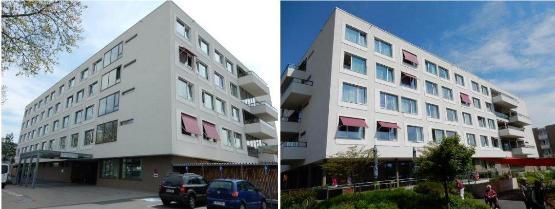
Abb.: Bezirkspflegeheim Gleisdorf mit dem Haupteingang an der Schillerstraße (links) und der gartenseitigen, nach Südosten orientierten Fassade (rechts)
