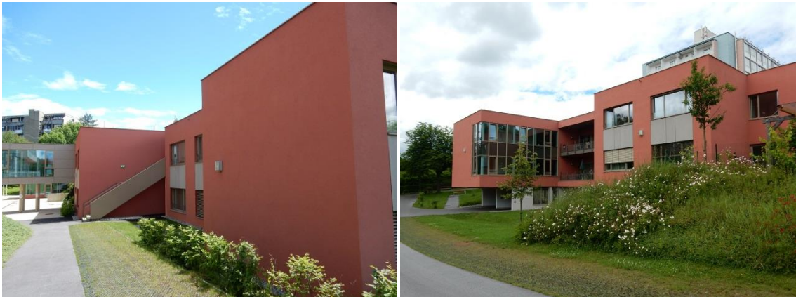
Abb.: Pflegeheim Rosenhain mit Blick von der Max-Mell-Allee auf die nördlich orientierte Seite des Neubaus mit der Verbindungsbrücke (links) und der südseitigen Ansicht in Richtung Max-Mell-Allee mit der Tiefgarageneinfahrt (rechts)
