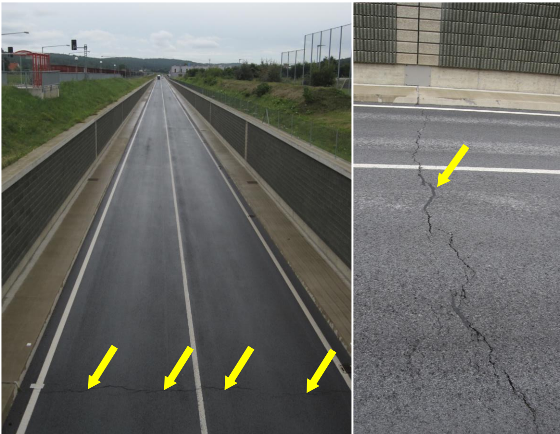
Abb.: Querrisse in der Fahrbahn der Wanne der B 64 im Bereich der Lahnstraßenbrücke
