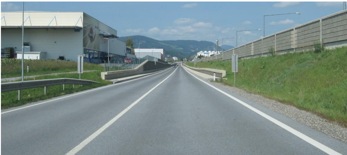
Abb.: B 64 neu entlang der Bahnlinie (rechts hinter Lärmschutzwand 3) ca. bei km 11,300 kurz vor der Einfahrt in das Wannengebäude; Fahrtrichtung Weiz (Nordwest)
