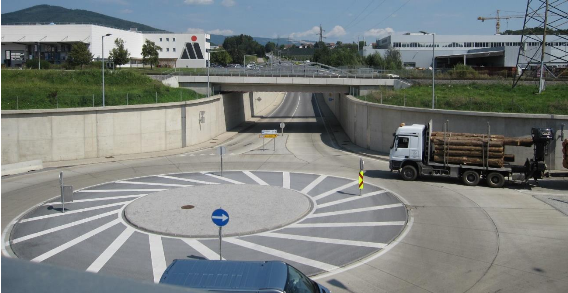
Abb.: Blick in Fahrrichtung Birkfeld von der Radwegbrücke über der B 72 auf die KVA B 64 / B 72 und die Wanne der B 72 mit der Unterführung unter der Landesbahn (Bahnbrücke) und die dahinterliegende Leitungsbrücke; rechts mündet die B 64 in die KVA
