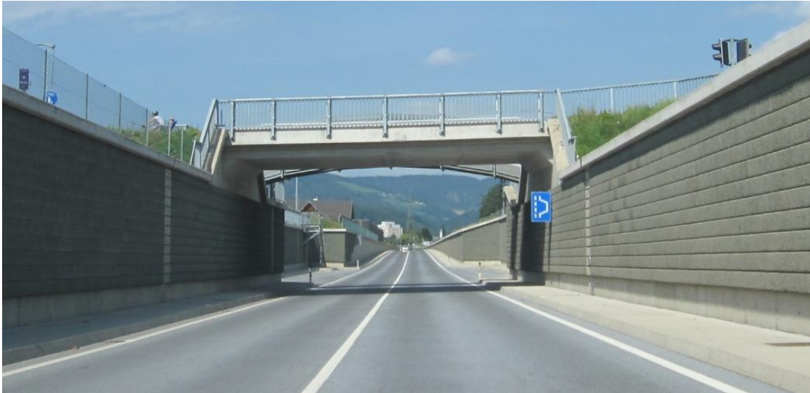
Abb.: Wannenbauwerk der B 64 in Fahrtrichtung Weiz (Nordwest) bei km 11,960; Lahnstraßenbrücke im Vordergrund mit dahinterliegender gebogener Leitungsbrücke sowie der darauffolgenden Querschnittsaufweitung für eine Pannabucht je Fahrtrichtung
