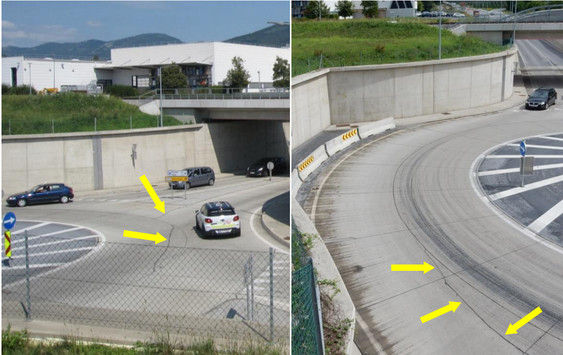
Abb.: Risse in einigen Segmenten der Betonfahrbahn der KVA B 64 / B 72
