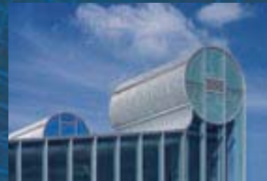
Station der U6 in Wien
