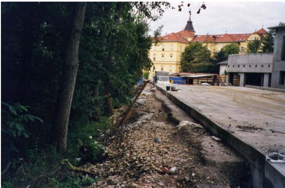
Die Abbildung zeigt die Konstruktion der Schlepp-Platten über der Tiefgaragendecke. Links von der Straße ist die Böschung zum Stiftingbach.
