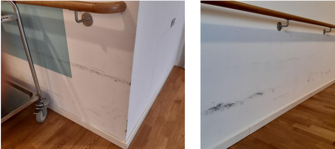
Abb.: Beschädigungen an Wänden und Kanten
