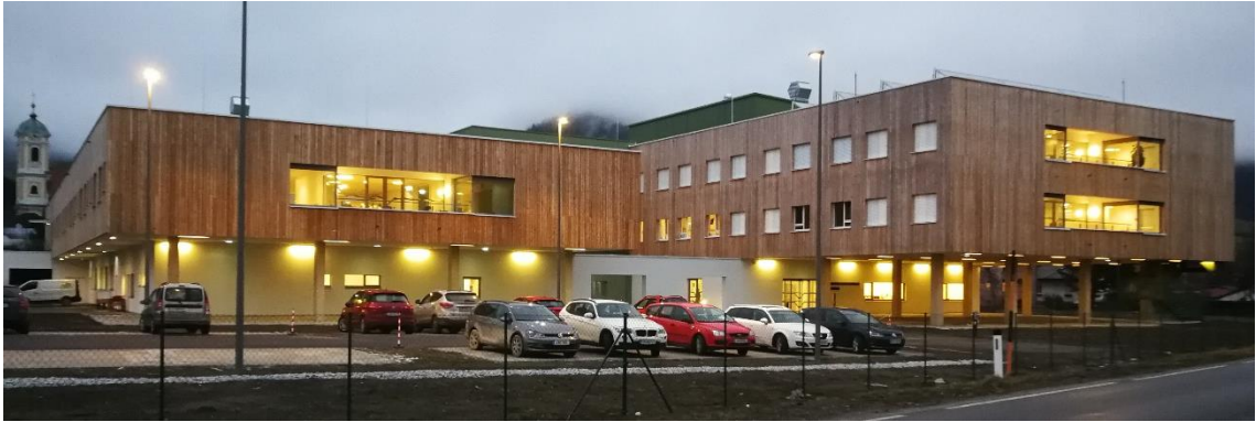
Abb.: LPZ Mautern von der Südseite (Bauteil 1 mit einem OG, Bauteil 2 mit zwei OG über dem EG), Jänner 2018; Quelle: A16
