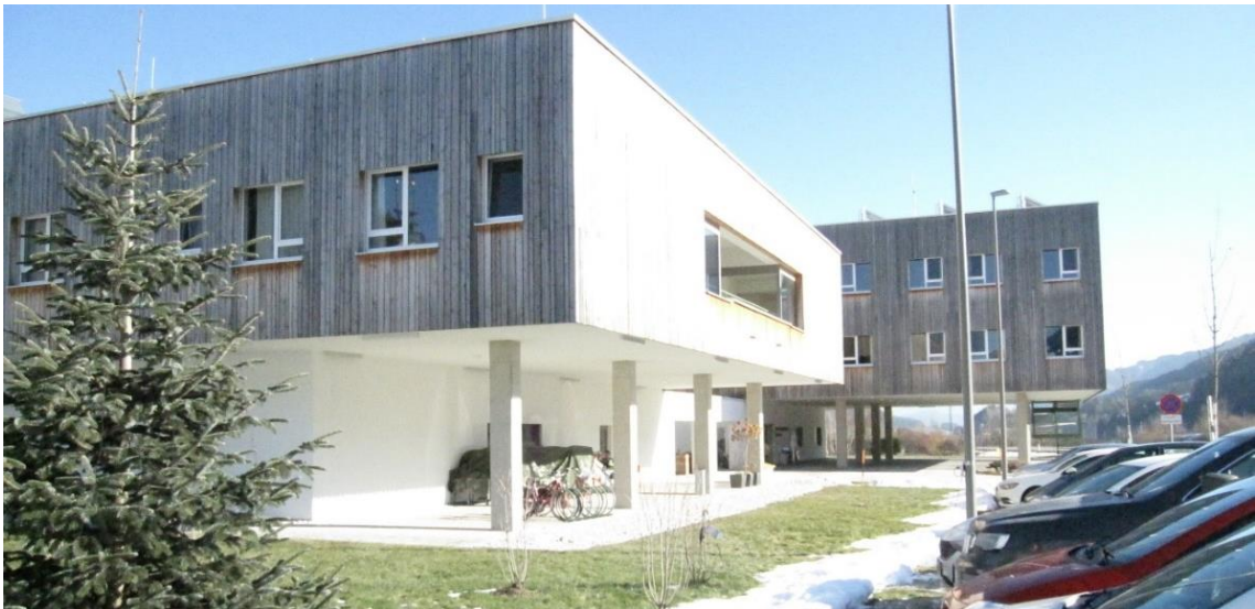
Abb.: Südseitige Auskragungen Bauteil 1 (im Vordergrund) und Bauteil 2 (hinten) mit dem witterungsgeschützten Eingangsbereich
