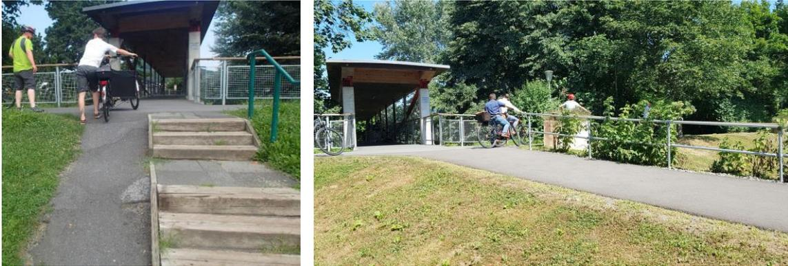
Abb.: Steile und schmale Rampe zum Raabsteg vor der Maßnahme (Foto links) und nach der Realisierung der flachen Anrampung für Fußgänger und Radfahrer (Foto rechts); Quelle: Foto links: A16
