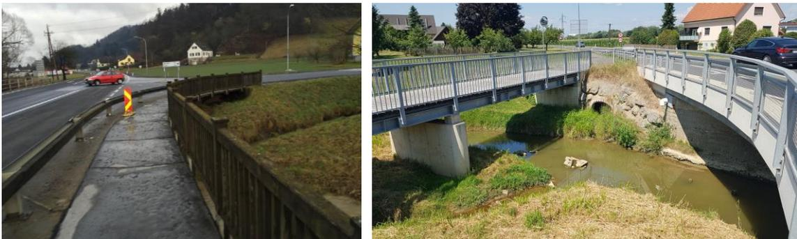
Abb.: GRW an der Berndorferstraße über die alte Straßenbrücke (Foto links) und die 2016 realisierte, getrennt geführte GRW-Brücke (links im rechten Foto); Quelle: Foto links: A16
