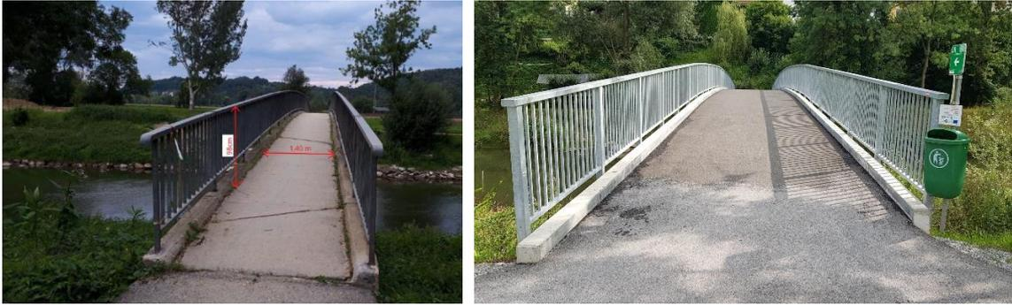
Abb.: Querschnitt des alten Kainachstegs (links) und des 2018 geplanten verbreiterten Stegs, der 2019 realisiert wurde (rechts); Quelle: Foto links: A16
