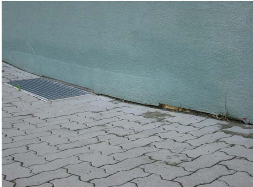
Die Traufpflasterschotterung besteht nur aus einer dünnen Schicht Rundkies, sodass – wie am nachfolgenden Bild ersichtlich – bereits Grasbewuchs vorhanden ist.
