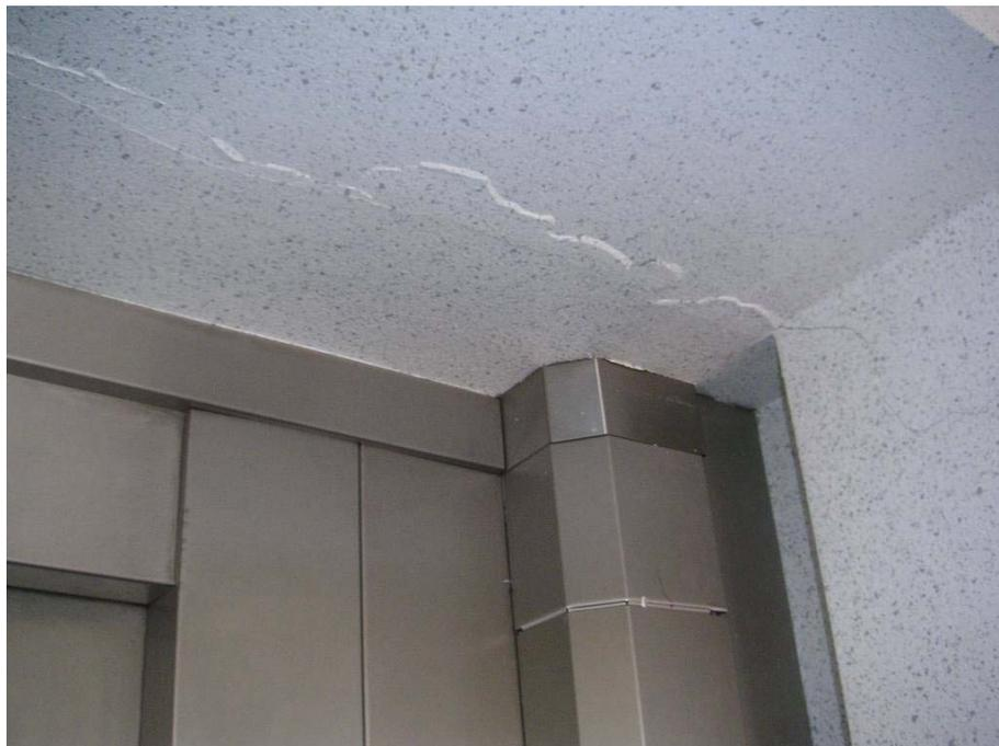
Im Bereich der Deckenübergänge zwischen den Stiegenhäusern und den Lift-einhausungen kommt es durch Setzungen zu Putzrissen. Die vorliegenden Schäden werden laut Aussage der GGW im Rahmen der Gewährleistung beseitigt. Die 3-jährige Gewährleistungsfrist ist noch nicht abgelaufen.
