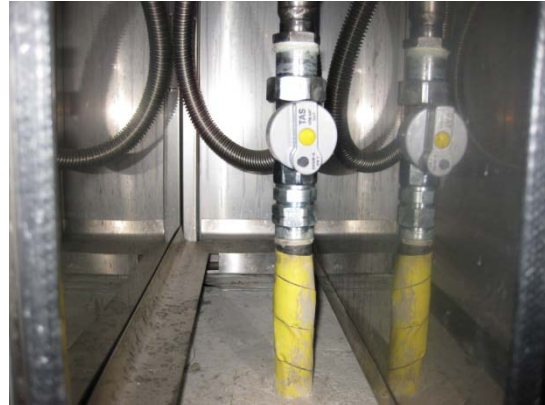
Bild 12 Absperrung mit TAS
