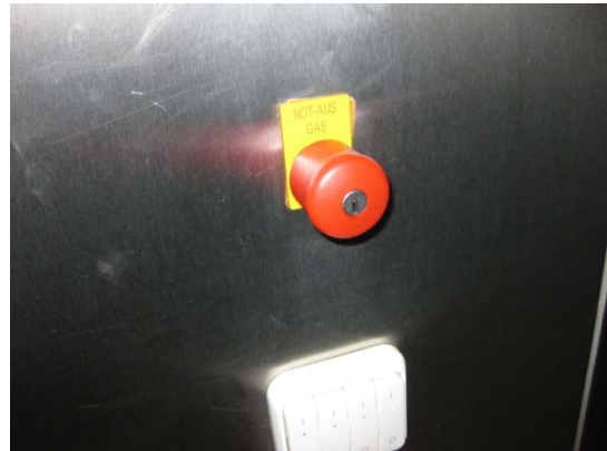
Bild 14 Gas-Not-Aus-Taster
