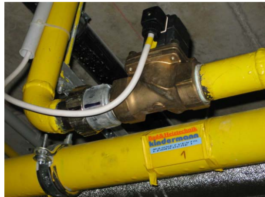
Bild 6 Magnetventil für Lehrküche „F“
