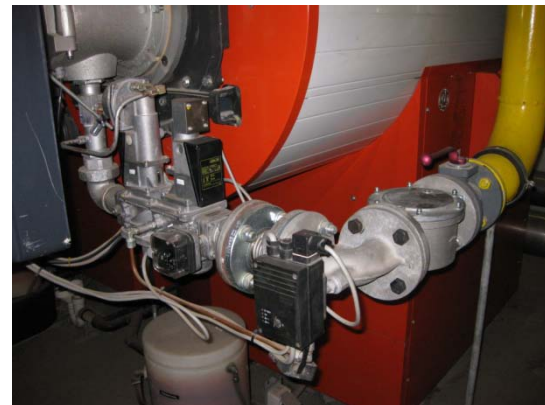
Bild 20 Gasregel- und Sicherheitsstrecke
