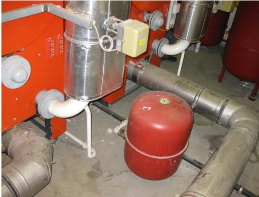
Bild 21 Abgasleitungen
