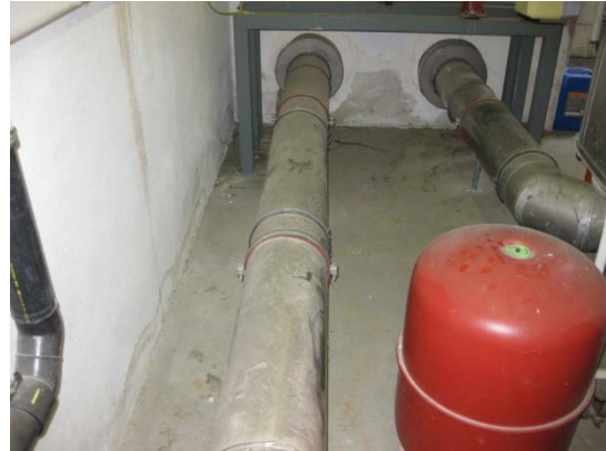
Bild 22 Abgasleitungen
