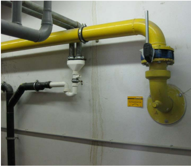
Bild 17 Gas-Hauptabspernung
