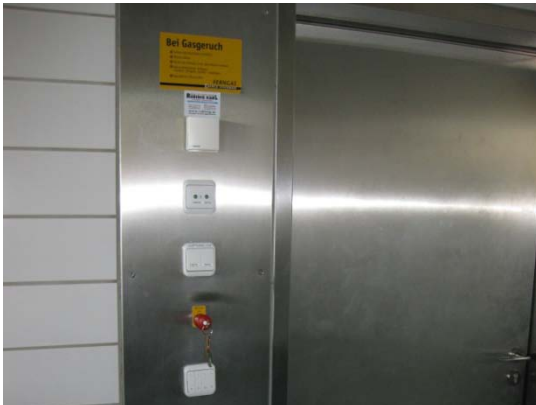
Bild 13 Tableau mit Notschalter
