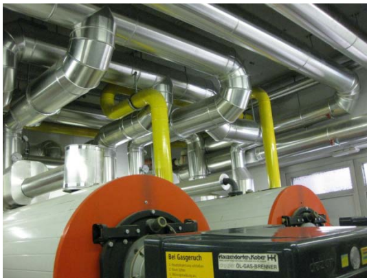
Bild 19 Gasanschlussleitungen
