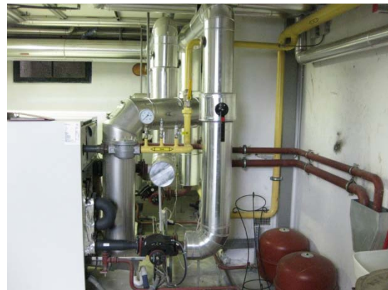
Bild 20 Anschlussleitungen
