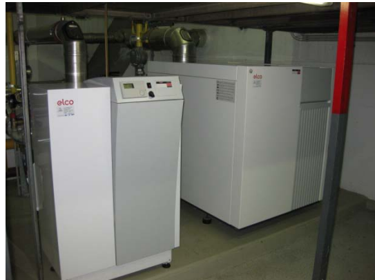
Bild 2 Zentralheizungskessel Rendamax 500
