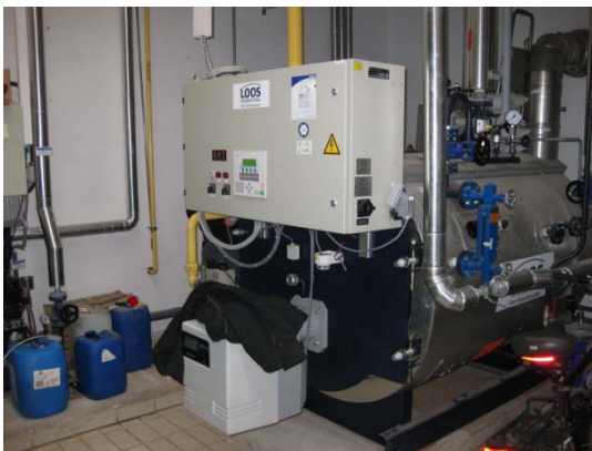
Bild 25 Dampfkesselanlage
