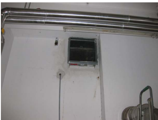
Bild 29 Zuluftöffnung Dampfkesselraum
