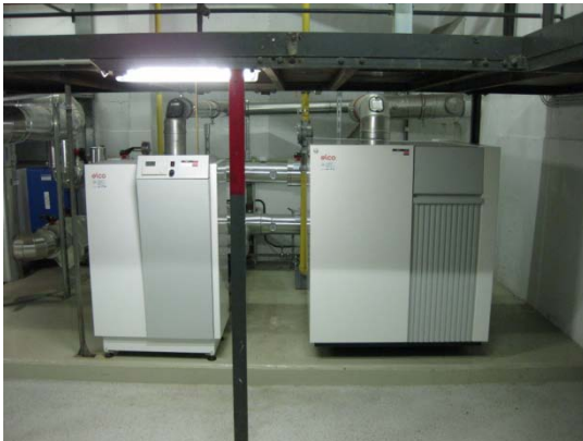
Bild 1 Zentralheizungskessel Rendamax 2900
