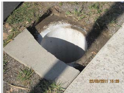
ungesichertes Betonrohr
