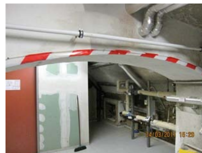
fehlender Kantenschutz
