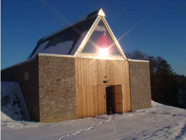
Hochbehälter Laßnitzhöhe; Quelle: WVTLO
