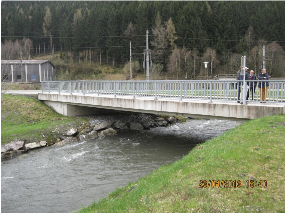
Abb. 7: neu errichtete Zufahrtsbrücke zum Betriebsareal der Fa. Lieco
