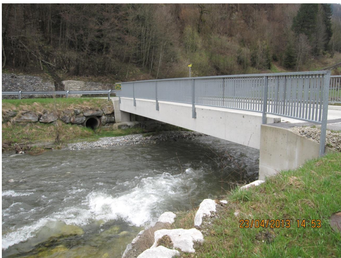
Abb. 12: neu errichtete Zufahrtsbrücke, Bereich Nord
