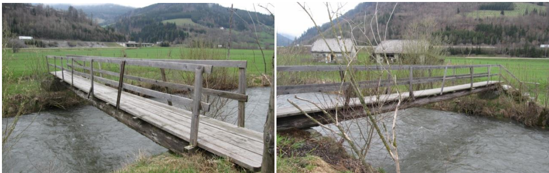
Abb. 21 und 22: Fußgängersteg im Bereich Dörfli
