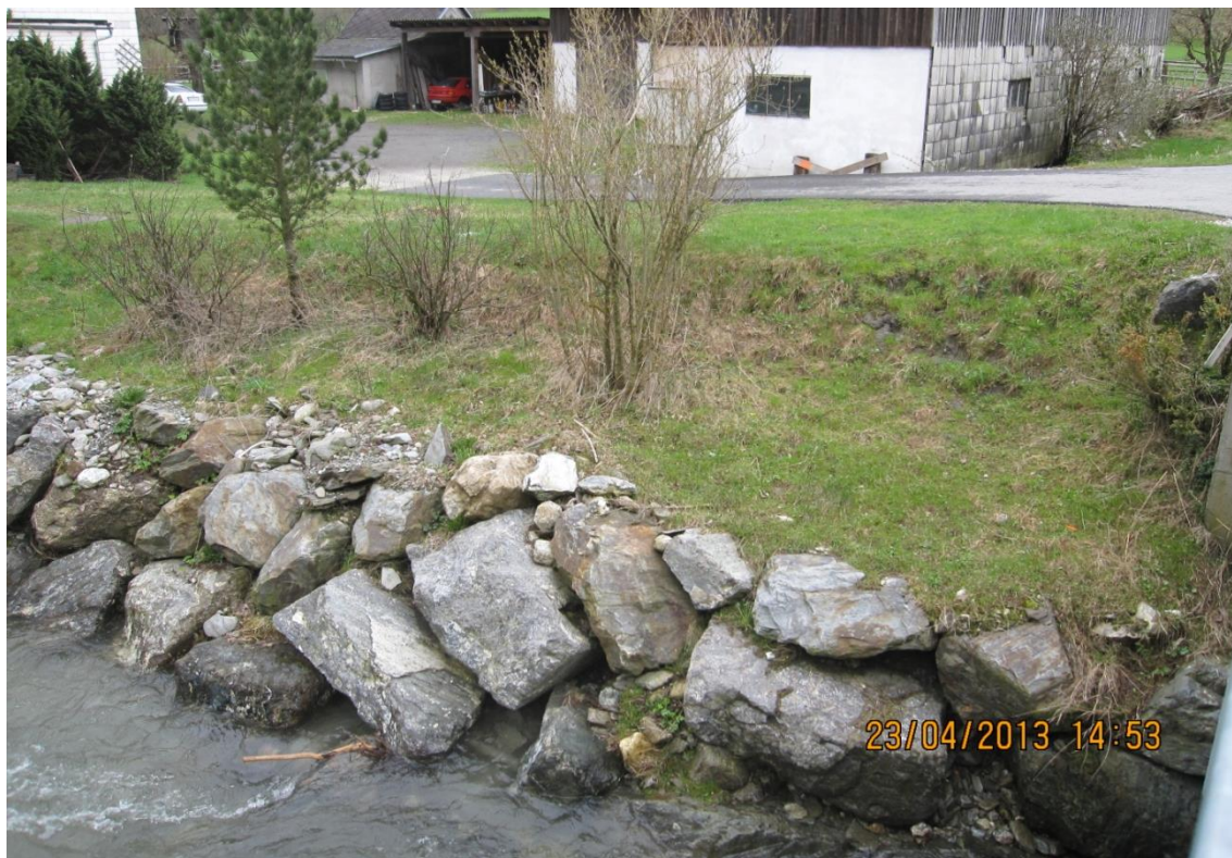
Abb. 11: Dammschüttung und Sicherung mittels Flussbausteinen, Bereich Nord
