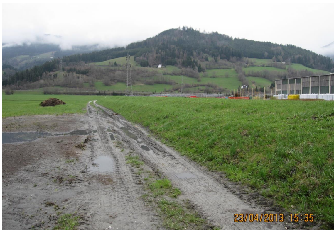
Abb. 4: Dammschüttung und Beginn der Flutmulde im westlichen Bereich der Fa. Lieco
