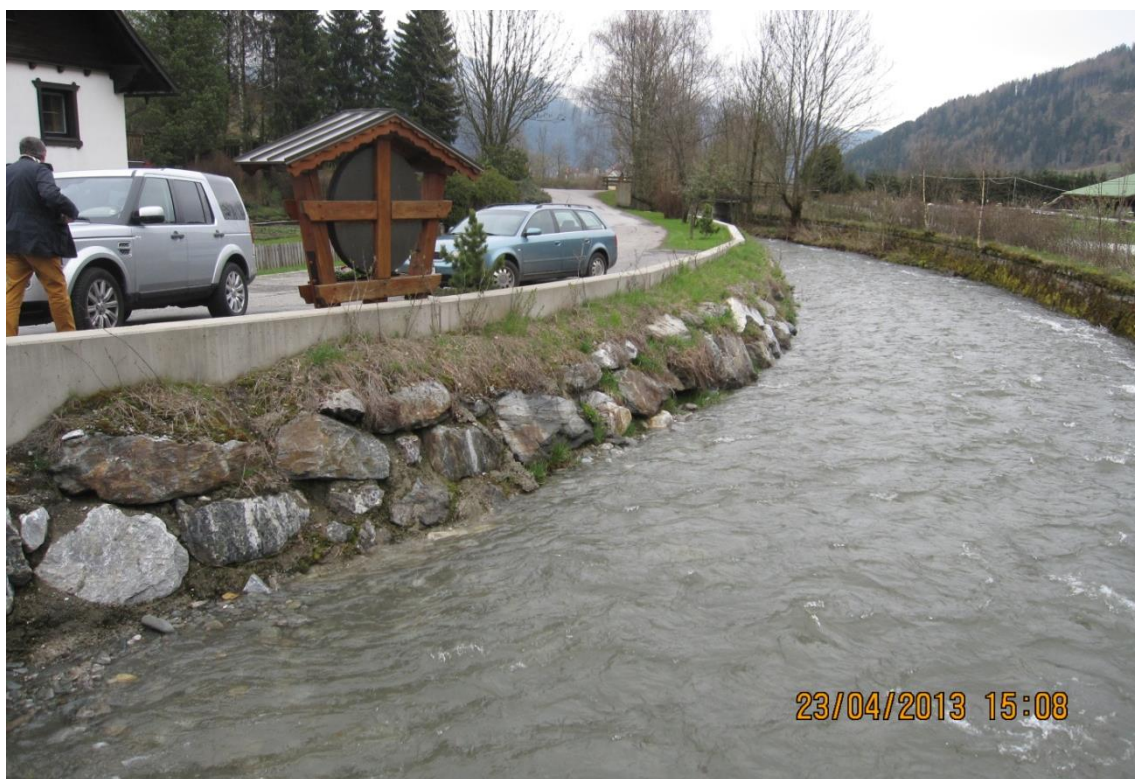
Abb. 16: Sicherung mittels Flussbausteinen und Schutzmauer, Bereich Fischzucht Iglar
