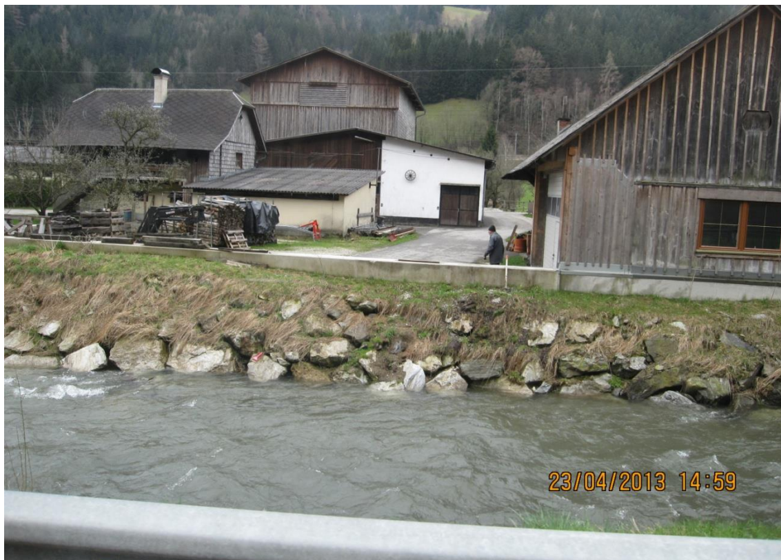
Abb. 13: Sicherung mittels Flussbausteinen und Schutzmauer, Bereich Nord
