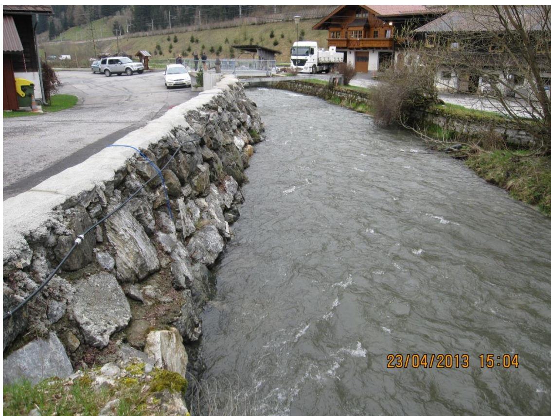
Abb. 14: Ufermauer im Bereich Fischzucht Iglér
