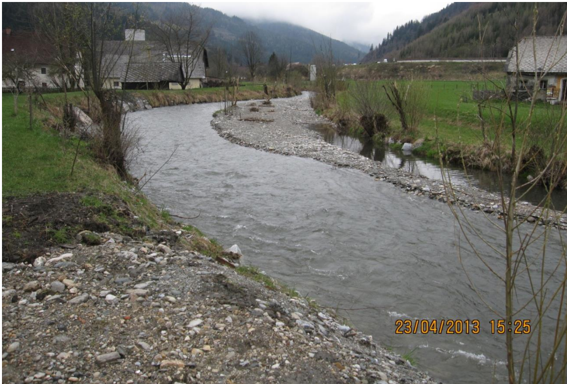
Abb. 17: Flussbettverlegung Bereich Dörfel
