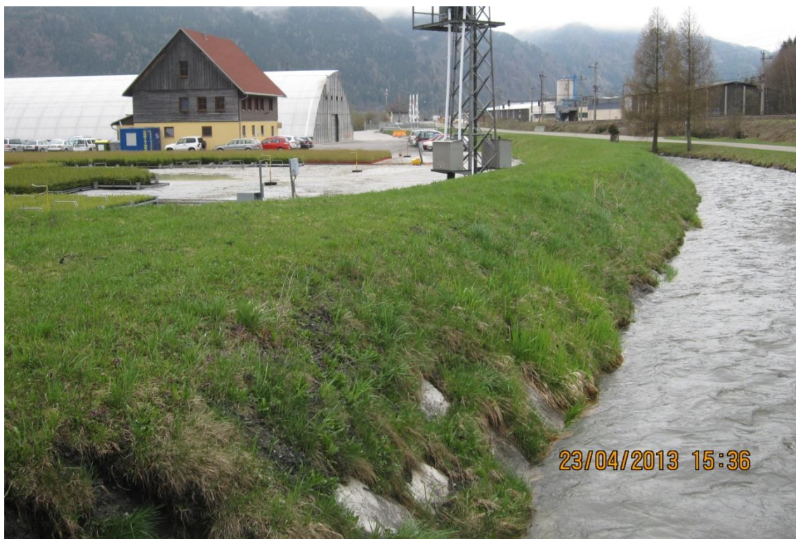
Abb. 5: Dammschüttung und Befestigung mit Wasserbausteinen an der Liesing im südlichen Bereich der Fa. Lieco
