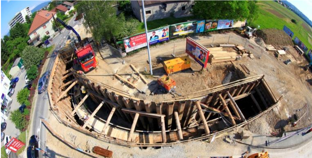
Kanalumlegung; Quelle: A16
