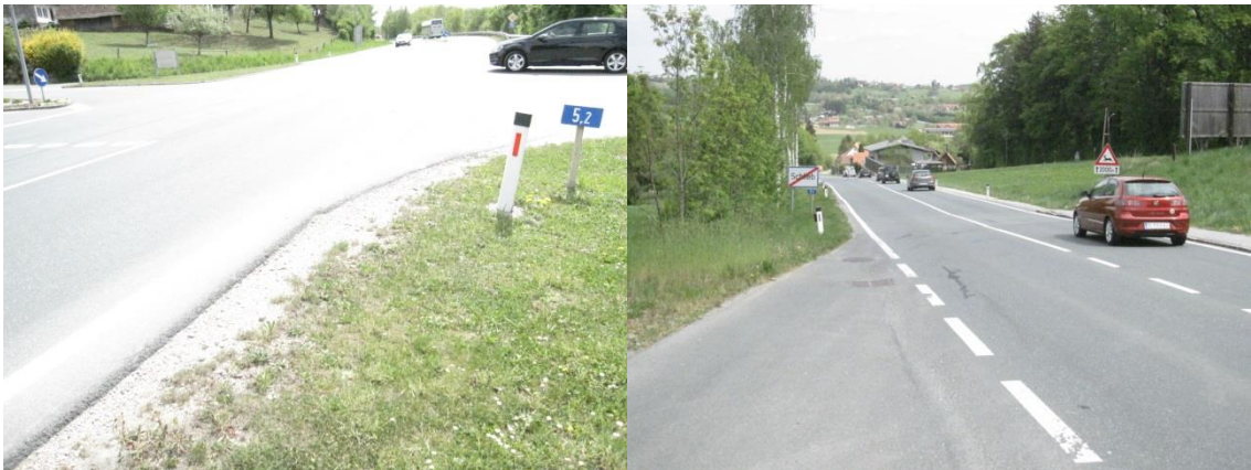
Abb.: Blickrichtung Projektbeginn und Projektende B 76
