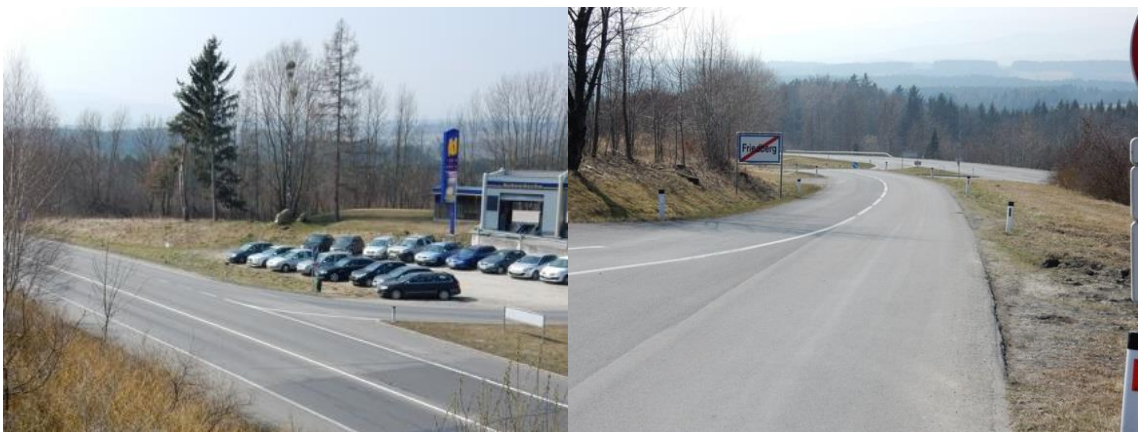
Abb.: Abschnittsanfang der B54 bei km 54,98 und Erweiterungsabschnitt Ast. Friedberg in Blickrichtung B54
