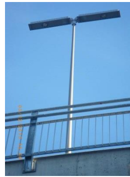
Geländer muraufwärts – Radwegseite
