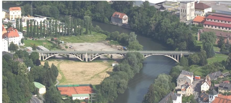
Alte Murbrücke Judenburg, Foto: D. Bauer
