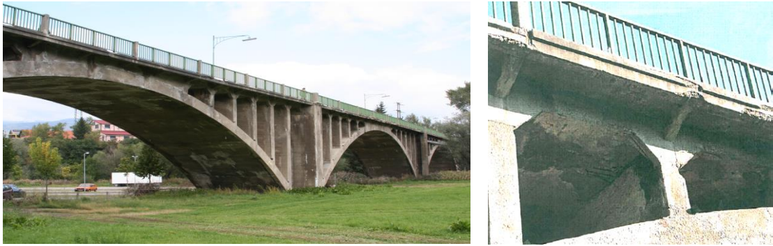
Foto: FA18B – Alte Murbrücke Judenburg
