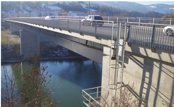
Quelle: LRH – Geländer murabwärts mit Wartungssteg
