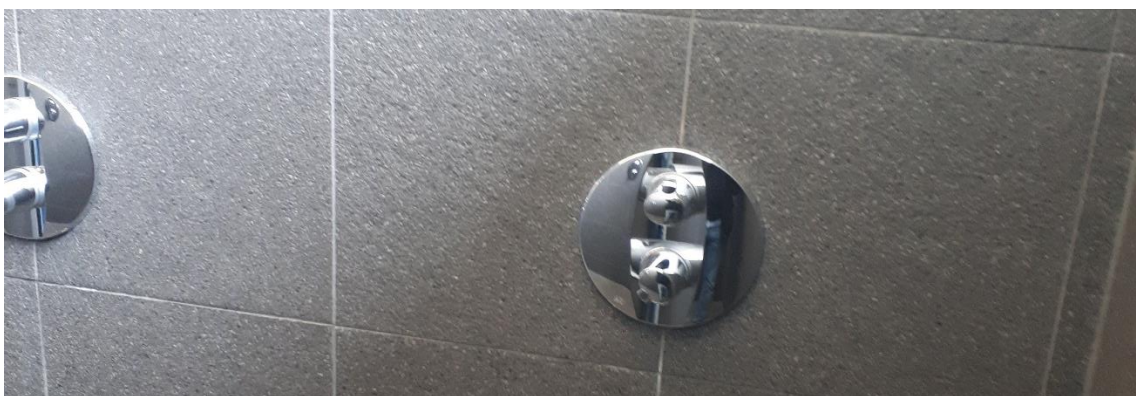
Abb.: Raue Wandfliesen in den sanierten Sanitärräumen
