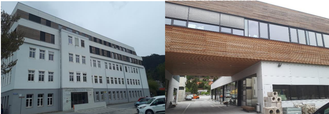
Abb.: LBS Murau mit dem sanierten Altbestand (links) sowie ein Teil des Neubaus (rechts)
