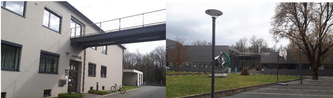
Abb.: Saniertes Direktionsgebäude (links) inkl. Verbindungssteg zu den drei neu errichteten Labor- und Werkstättegebäude (rechts)
