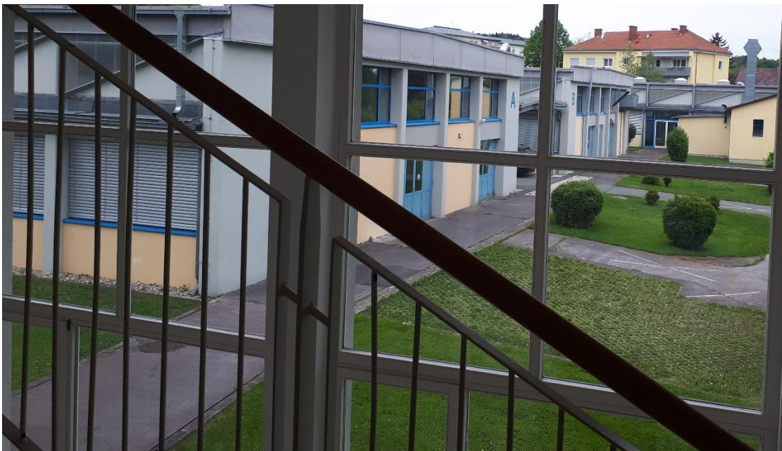
Abb.: LBS Arnfels mit Blick auf die Werkstättegebäude
