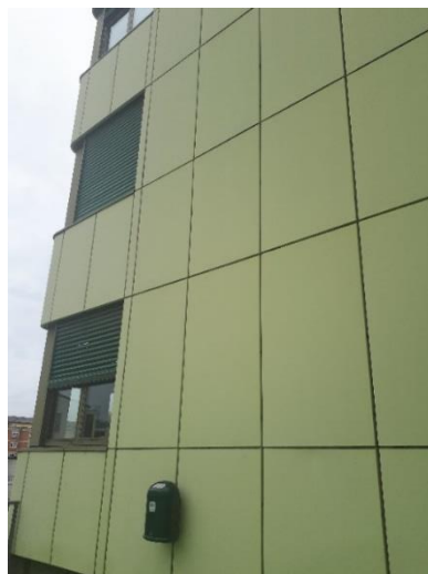
Abb.: Fassadenelemente, die wiederverwendet werden sollen
