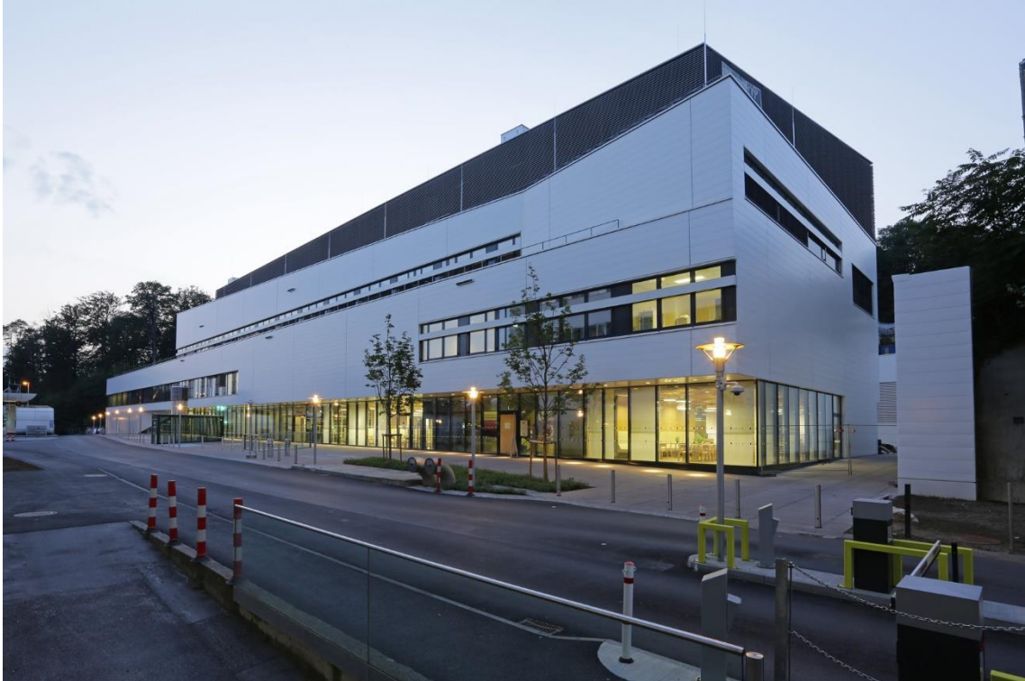
Abb.: Außenansicht des VZ 18
