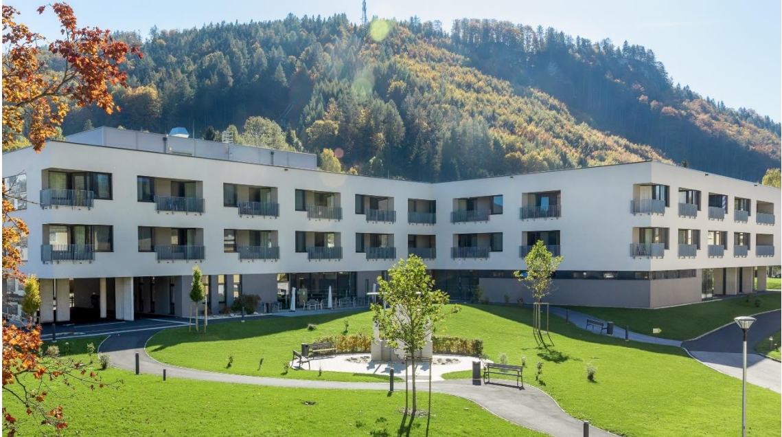
Abb.: Außenansicht des LPZ Mürzzuschlag 16
