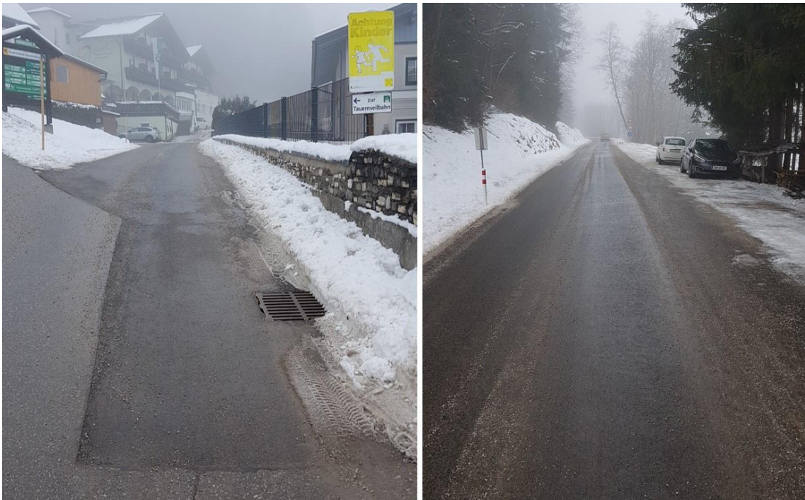
Abb.: Oberhausbergweg nach der Sanierung – Projektanfang an der Kreuzung mit der Kaiblingstraße (links) und Wegverlauf ca. 100 m nach Projektanfang (rechts)
