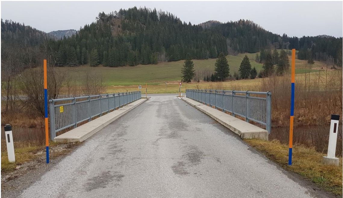
Abb.: Mooshubenstraße über die Mooshubenbrücke (Fahrtrichtung Kreuzung mit Landesstraße B21)
