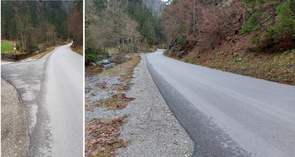
Abb.: Projektanfang der sanierten Hinterwildalpenstraße bei der Brücke (links) über den Hinterwildalpenbach nach der Sanierung und weiterer bachbegleitender Straßenverlauf Richtung Hinterwildalpen
