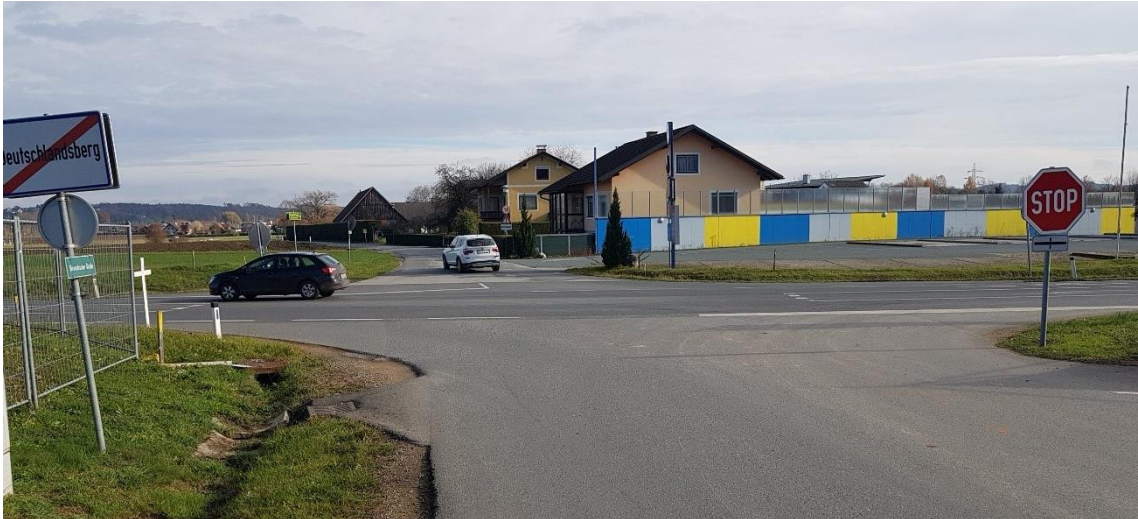
Abb.: Anfangsbereich des Sanierungsabschnitts der Bösenbacher Straße an der Kreuzung mit der B76 Radlpass Straße (Blickrichtung Projektanfang)
