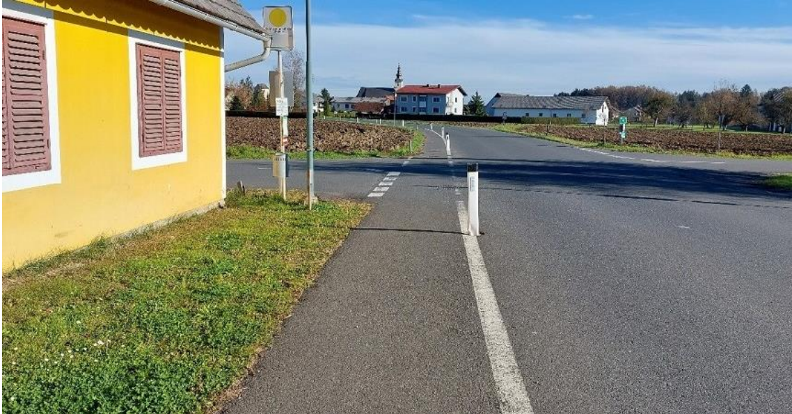
Abb.: Wolframstraße - Fahrbahn und Gehweg (Fahrtrichtung St. Martin im Sulmtal)
