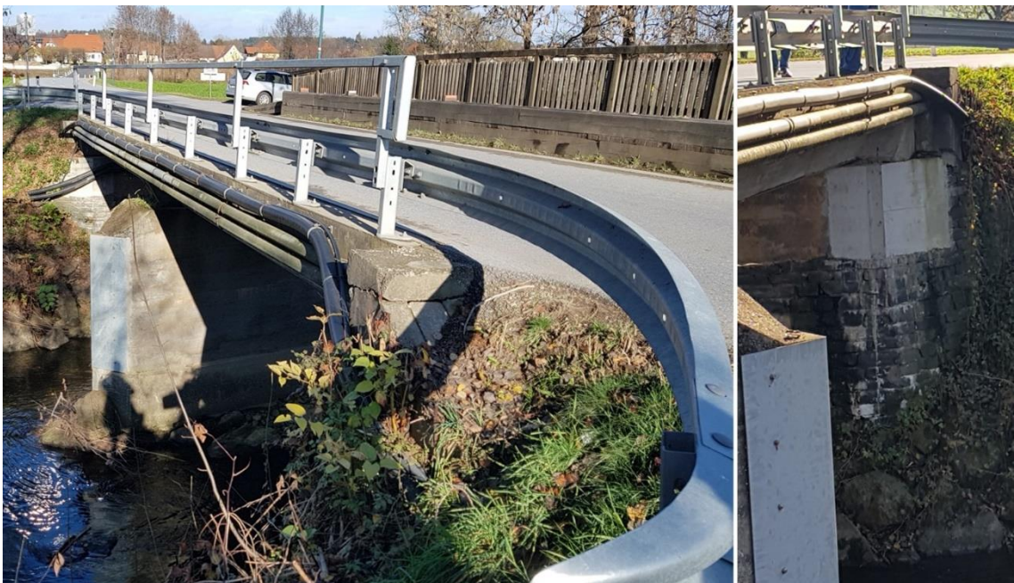
Abb.: teilsanierte Brücke über die Schwarze Sulm mit Widerlagersanierung (Spritzbeton), Stahlblechverkleidung des sanierten Mittelpfeilers, Steinschichtung als Kolkschutz bei Widerlager und Mittelpfeiler
