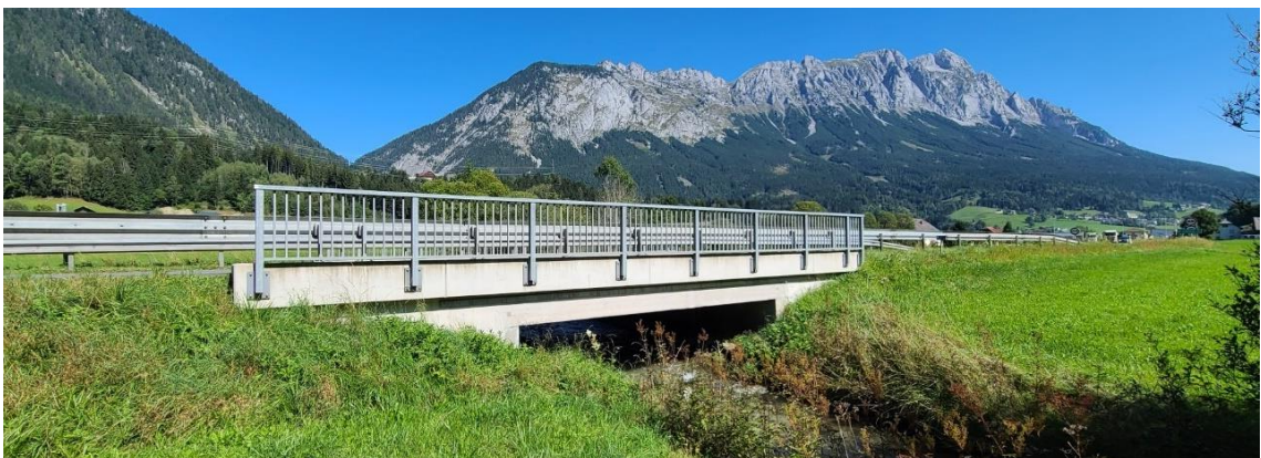
Abb.: sanierte Gröbmingbachbrücke mit erneuertem Randbalken mit seitlich montiertem Geländer und neuen Leitschienen
