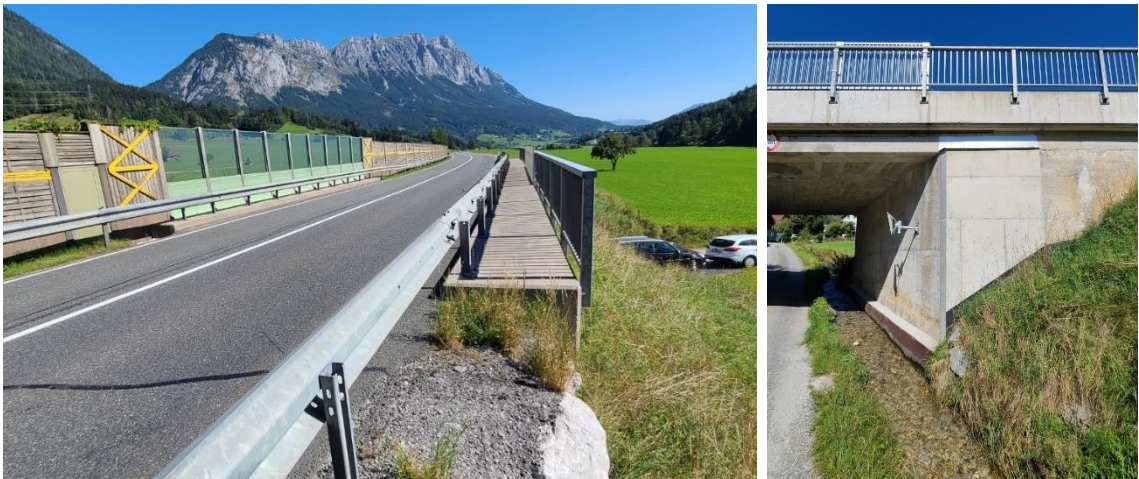
Abb.: links: neue Leitschienen und seitlich am erneuerten Randbalken montierte Geländer sowie wiederverwendete Lärmschutzelemente der Lengdorfbachbrücke auf der B 320 Ennstal Straße (Fahrtrichtung Liezen); rechts: Lengdorfbach entlang des verstärkten Widerlagersockels; Verstärkung des Unterbaues; erneuertes Randbalken mit Geländer inkl. Spritzschutz im Bereich über der Fahrbahn des Unterlengdorfweges
