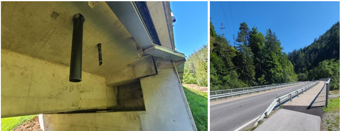
Abb.: links: Betonsanierungen am Widerlager und Tragwerk der Kaiser-Josef-Brücke rechts: B 23 Lahnsattel Straße über die Kaiser-Josef-Brücke (Fahrtrichtung Mariazell) mit dem verbreiterten Randbalken (rechts)
