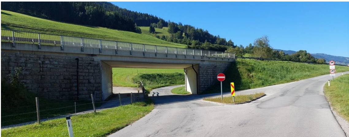
Abb.: Rampenunterführung Schladming-Oberhaus: Unterführung der Abfahrtsrampe von der B 320 kommend, rechts führt die Auffahrtsrampe zur B 320 Richtung Schladming.
