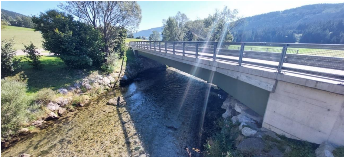
Abb.: 2016 errichtete Salzabrücke ohne Mittelpfeiler
