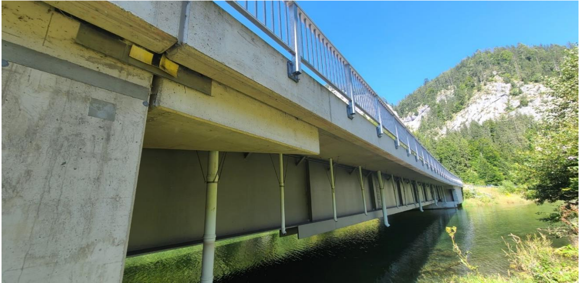
Abb.: Blick entlang der angehobenen Riesbrücke über die Mürz in Fahrtrichtung Mürzzuschlag auf Höhe des Widerlagers: mit Stahllaschen am Untergurt verstärkter und neu beschichteter Stahlhauptträger; Brückenenwässerung aus den erneuerten Stahlbetonkragplatten
