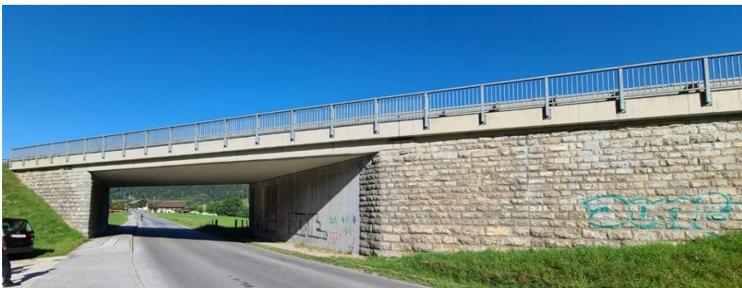
Abb.: Unterführung Oberhaus: die Oberhausstraße unterquert die B 320 Ennstal Straße
