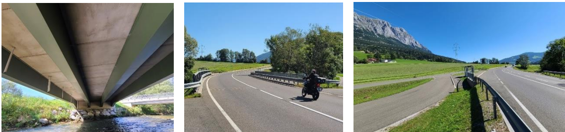
Abb.: links: Untersicht des Tragwerks (Stahlträger mit Betonplatten) der Salzabrücke; Mitte: B 320 Ennstal Straße über die Salzabrücke in Fahrtrichtung Liezen; rechts: Zusatzprojekt mit neuer Busbucht direkt an der B 320 (vom Widerlagerbereich der Salzabrücke Fahrtrichtung Liezen) mit Linksabbiegespur zur Umkehrschleife
