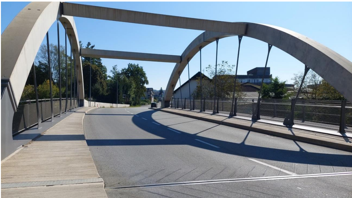
Abb.: Die B 65 Gleisdorfer Straße über die Raabbrücke (Blick in Fahrtrichtung Gleisdorf Zentrum): Stahlbetonbogentragwerk mit Querstreben und Stahlabhängungen der Fahrbahn, Fahrbahnübergang im Vordergrund mit verstärkter angrenzender Asphaltbelagszone (schräge Rippen)
