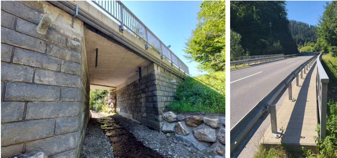
Abb.: Tebringbachbrücke nach den Instandsetzungen von 2016
