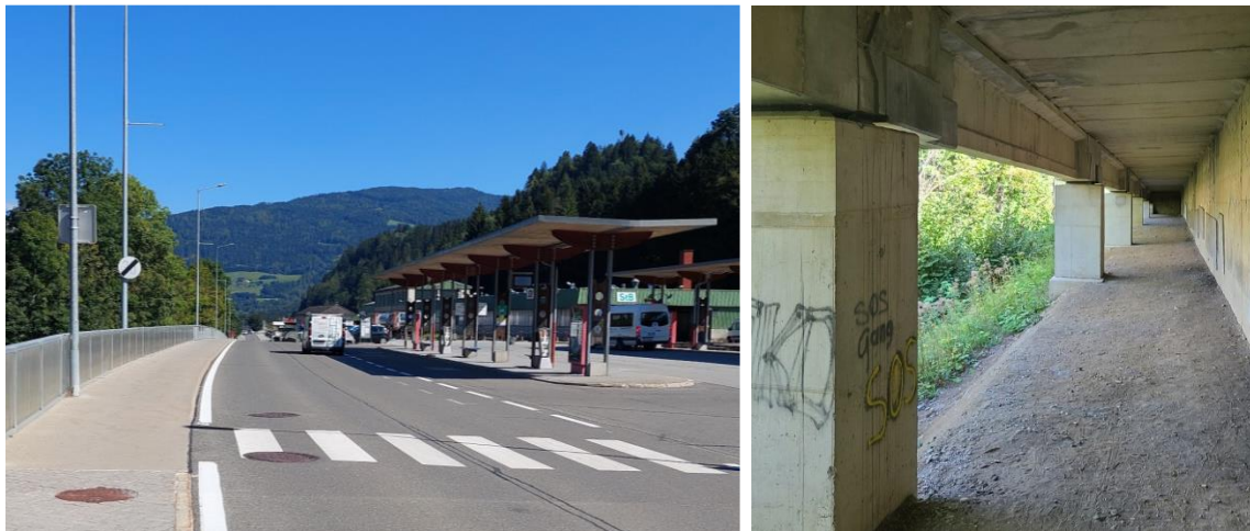
Abb.: links: Hangbrücke Murau mit Blick entlang des Randbalkens im Bereich des Bahnhofs Murau rechts: sanierte Pfeiler, Längsträger und Winkelstützmauer unter der Fahrbahn im Bereich des Bahnhofs Murau
