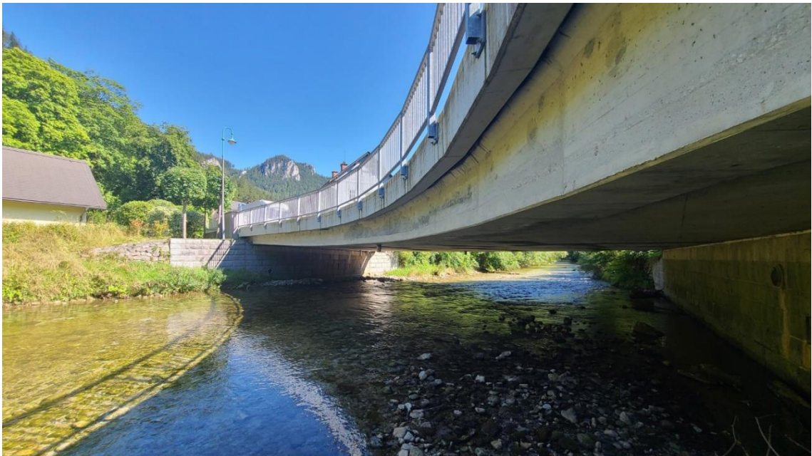
Abb.: Fahrtrichtung Mürzsteg – Blick auf Widerlager, Brückenuntersicht, Randbalken und Geländer
