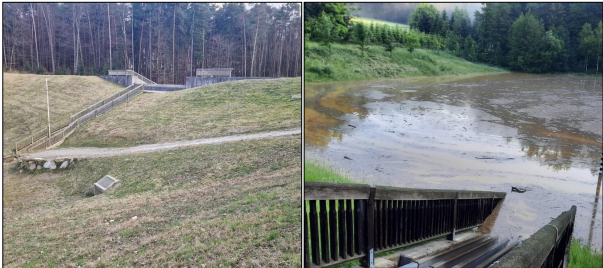
Abbildung: Rückhaltebecken Kroisbach im leeren und im bis zu 40 % gefüllten Zustand; Quelle: A14
