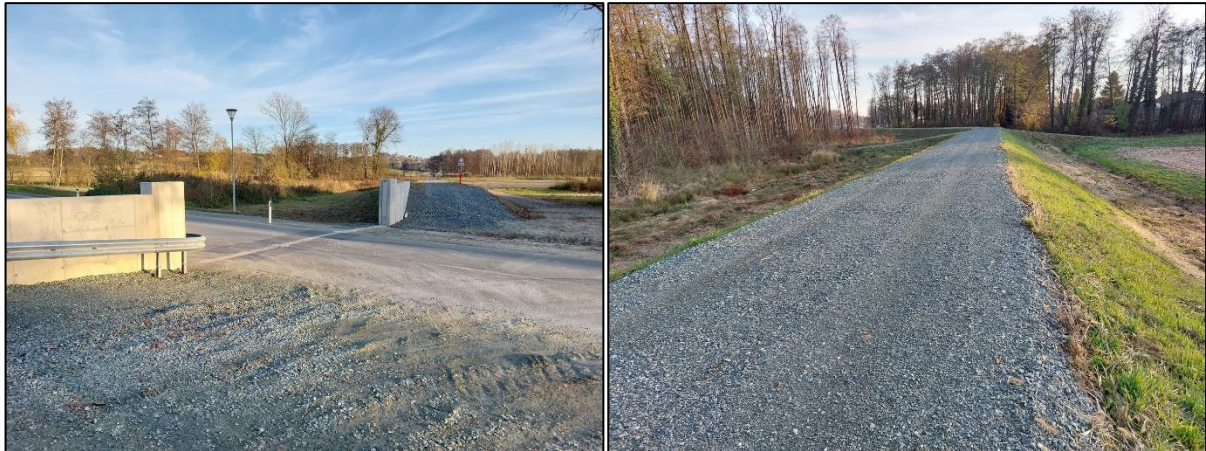
Abbildung: Projekt Lafnitz, Linearmaßnahmen – aufgenommen am 11. November 2025
