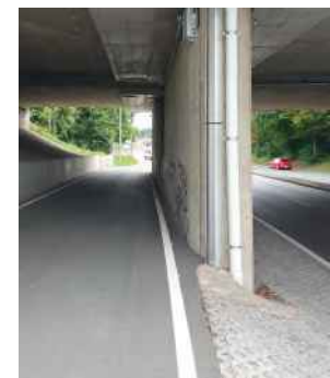
Abbildung: Geh- und Radweg hinter dem Brückenpfeiler; Blick von Westen; Aufnahme vom 29. Juli 2025
