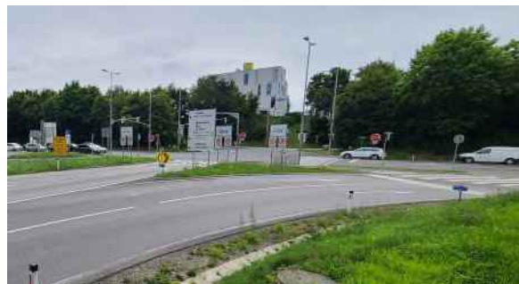
Abbildung: Blick auf die Abfahrts-Rampe A Richtung Süden nach der Sanierung: Aufweitung auf zwei Fahrstreifen Richtung Liebenau; Aufnahme vom 29. Juli 2025
