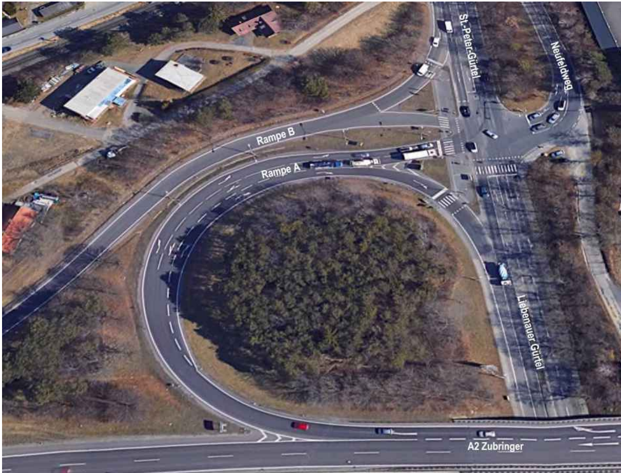
Abbildung: Knoten St.-Peter-Gürtel und Einmündung Neufeldweg: Blickrichtung von West (Liebenau) nach Ost vor der Projektumsetzung: Rampe A mit der Abfahrt vom A 2-Zubringer zum St.-Peter-Gürtel und zum Liebenauer Gürtel und Rampe B mit der Auffahrt zum A 2-Zubringer aus Liebenau und St. Peter; Quelle: Google Earth, © 2025 Google, Aufnahme vom 10. März 2022; abgerufen am 9. September 2025; Beschriftungen durch den Landesrechnungshof
