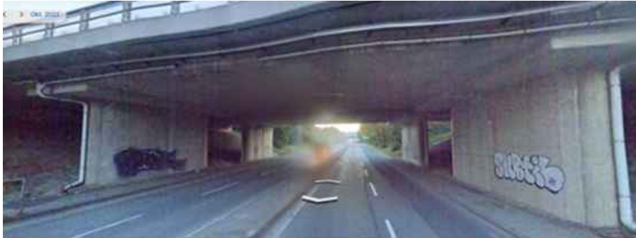
Abbildung: Blick vom Liebenauer Gürtel auf die A 2-Zubringer-Unterquerung in Fahrtrichtung Osten vor der Projektumsetzung: zwei Fahrstreifen pro Richtung und beidseitiger Geh- und Radweg zwischen den Brückenpfeilern; Quelle: Google Earth, © 2025 Google, Aufnahme vom Oktober 2022, abgerufen am 8. September 2025
