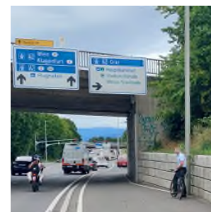
Abbildung: Einengung Geh- und Radweg unter der Brücke; Blick von Osten; Aufnahme vom 29. Juli 2025
