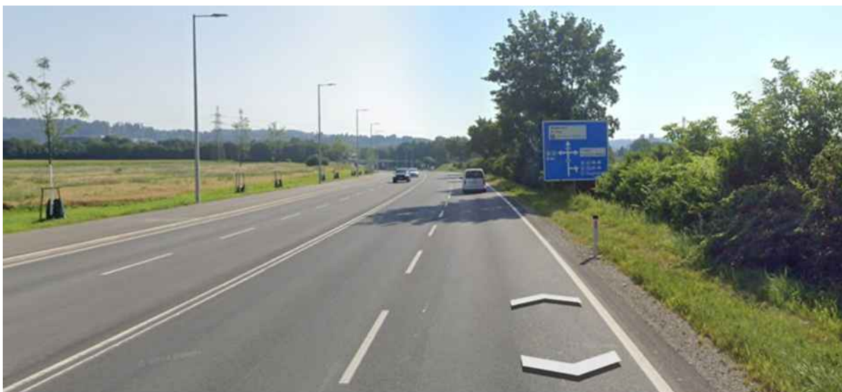
Abbildung: Der generalsanierte Liebenauer Gürtel in Fahrtrichtung Osten ca. bei km 12,2; Quelle: Google Earth, © 2025 Google, Aufnahme von Juli 2024; abgerufen am 25. August 2025
