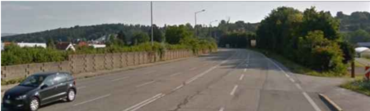
Abbildung: Die Grazer Ring Straße am St.-Peter-Gürtel in Fahrtrichtung Osten vor der Sanierung; Quelle: Google Earth, © 2025 Google, Aufnahme von Juli 2018; abgerufen am 2. Oktober 2025
