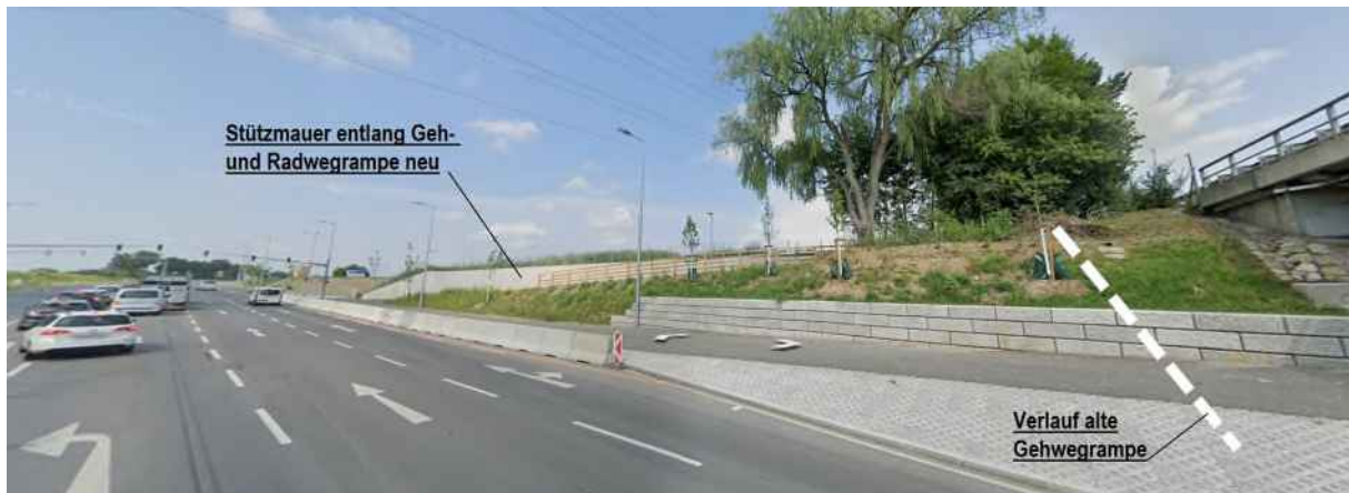
Abbildung: Liebenauer Gürtel in Fahrtrichtung Westen im Bereich der Autobahnzubringer-Brücke: die um 70 m versetzte Geh- und Radwegrampe mit begleitender Stützmauer nach den Umbaumaßnahmen; Quelle: Google Earth, © 2025 Google, Aufnahme vom Juli 2024, abgerufen am 4. September 2025; Beschriftungen durch den Landesrechnungshof
