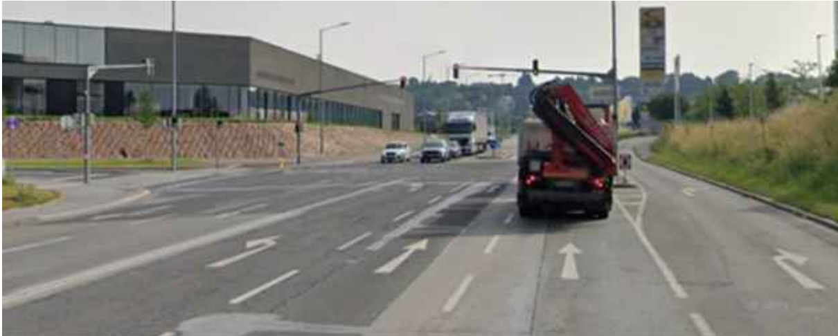
Abbildung: Anfahrt zur Einmündung Maggstraße (Linksabbiegefahrstreifen) und zur Zufahrtsrampe zum Center Ost (rechts) in Fahrtrichtung Osten – erkennbare Fahrbahnschäden vor der Sanierung; Quelle: Google Earth, © 2025 Google, Aufnahme vom Juni 2021, abgerufen am 29. September 2025
