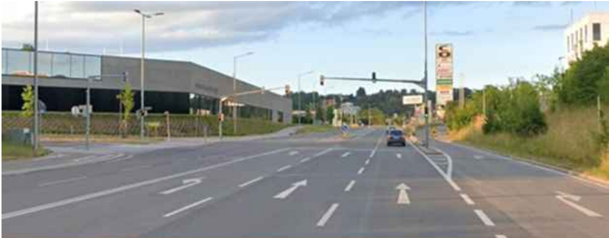
Abbildung: Anfahrt zur Einmündung Maggstraße (links) und zur Zufahrtsrampe zum Center Ost (rechts) in Fahrtrichtung Osten nach der Sanierung – im Asphaltbelag erkennbare Projektschnittstelle: nicht im Projekt enthaltene Zufahrtsrampe Center Ost; Quelle: Google Earth, © 2025 Google, Aufnahme vom Juni 2025, abgerufen am 29. September 2025
