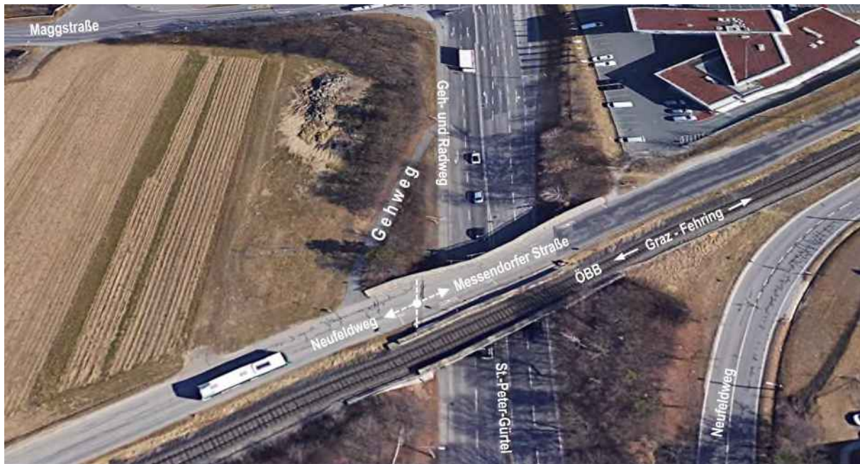
Abbildung: Abzweigender Gehweg vom St. Peter-Gürtel zum höher gelegenen Neufeldweg vor den Umbaumaßnahmen; Quelle: Google Earth, © 2025 Google, Aufnahme vom 10. März 2022, abgerufen am 26. September 2025; Beschriftungen durch den Landesrechnungshof
