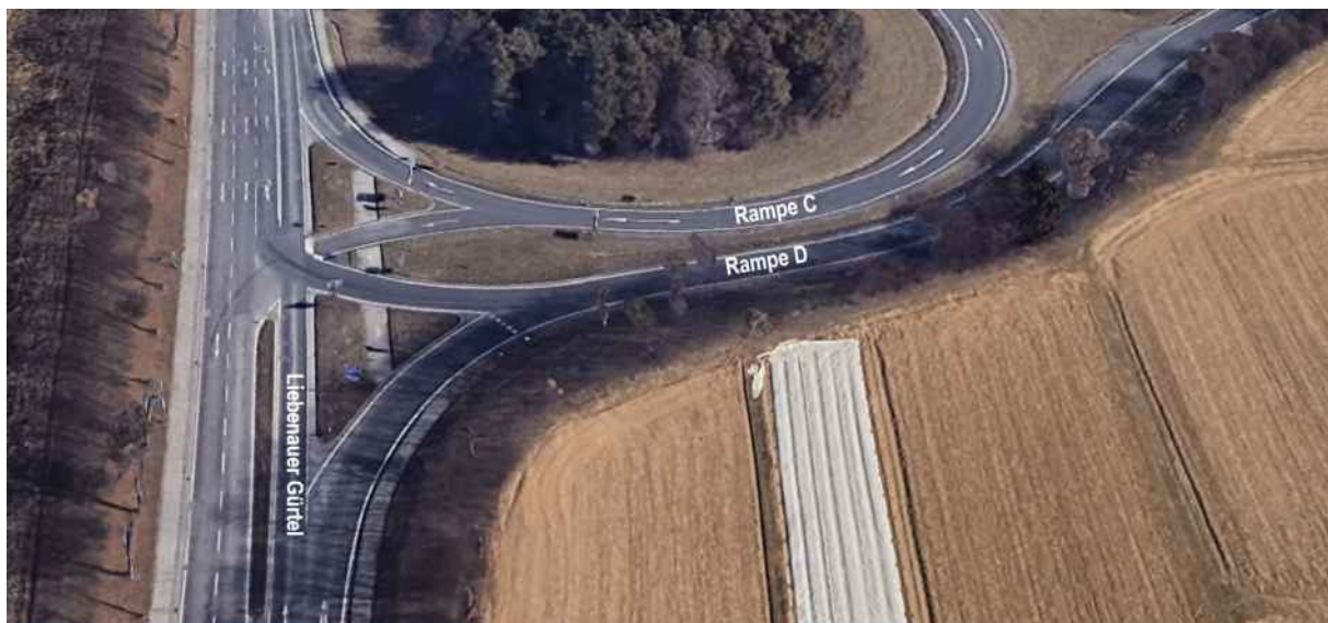
Abbildung: Knoten Liebenauer Gürtel – Rampen C/D vor der Generalsanierung: Blickrichtung von West (Liebenau) nach Ost vor der Projektumsetzung: Rampe C mit der Abfahrt vom A 2-Zubringer zum Liebenauer Gürtel in beide Fahrtrichtungen und Rampe D mit der Auffahrt zum A 2-Zubringer aus West (Liebenau) und Ost (St. Peter); beide Rampen vom südlichen Geh- und Radweg gequert; Quelle: Google Earth, © 2025 Google, Aufnahme vom 10. März 2022; abgerufen am 28. August 2025
