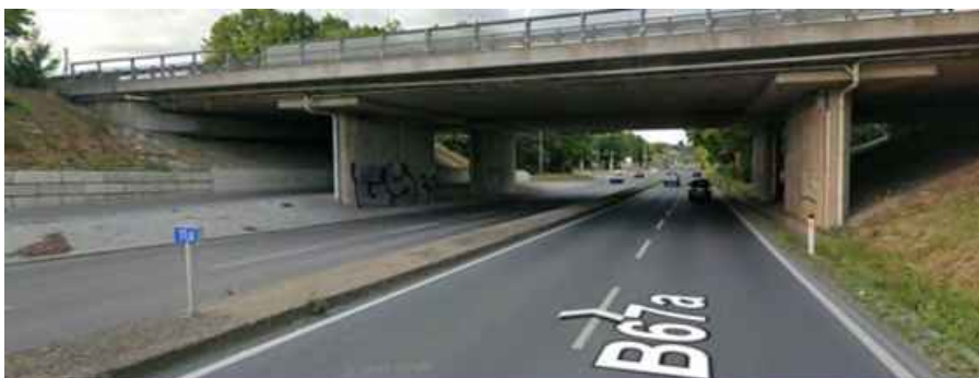
Abbildung: Blick vom Liebenauer Gürtel auf die A 2-Zubringer-Unterquerung in Fahrtrichtung Osten nach der Projektumsetzung: zwei Fahrstreifen pro Richtung zwischen den Brückenpfeilern, Geh- und Radweg nur noch einseitig hinter dem nördlichen Brückenpfeiler; Quelle: Google Earth, © 2025 Google, Aufnahme vom Juni 2025, abgerufen am 8. September 2025
