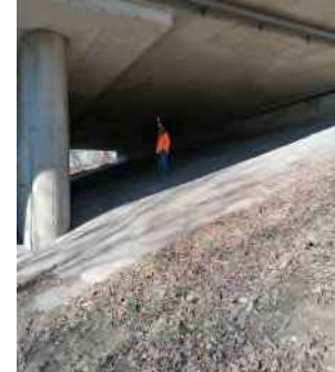
Abbildung: Böschung hinter dem Brückenpfeiler; Blick von Osten; Quelle: A16, Aufnahme vom 12. März 2020
