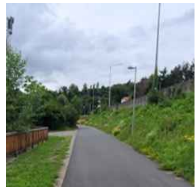
Abbildung: Geh- und Radweg am Böschungsfuß der B 67a; Blick Richtung Osten; Aufnahme vom 29. Juli 2025
