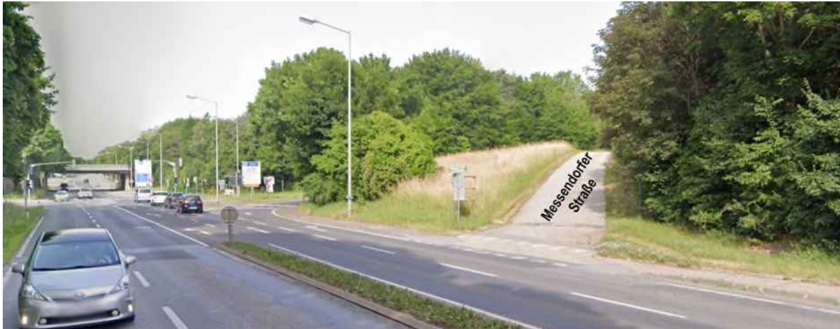
Abbildung: Einmündung Messendorfer Straße vom St.-Peter-Gürtel aus mit Blickrichtung Nordwest vor der Projektumsetzung; Quelle: Google Earth, © 2025 Google, Aufnahme vom Juni 2021; abgerufen am 23. September 2025; Beschriftung durch den Landesrechnungshof
