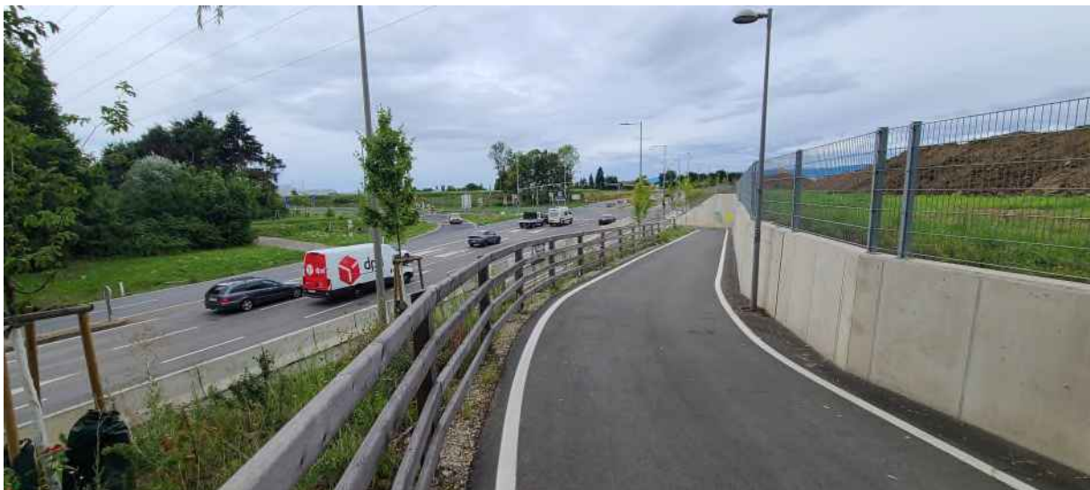
Abbildung: Blick auf die Geh- und Radwegrampe und den Liebenauer Gürtel in Fahrtrichtung Westen von der Böschungsoberkante am abzweigenden Geh- und Radweg; Aufnahme vom 29. Juli 2025
